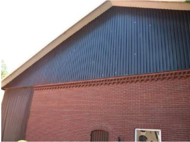
De betimmering van het dakoverstek en de damwandplaten sluiten strak aan op de buitengevels.
