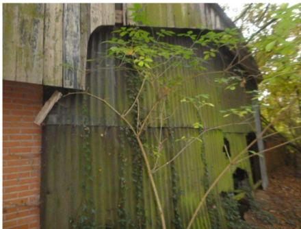
Onduline beplating veeschuur 1
