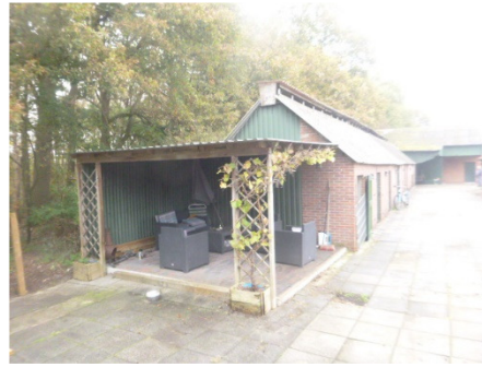
Afdak en veeschuur 2
