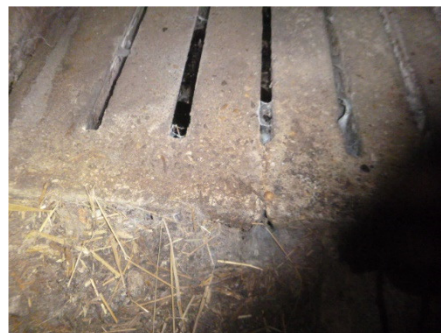
Inspectie mestkelder via roosters
