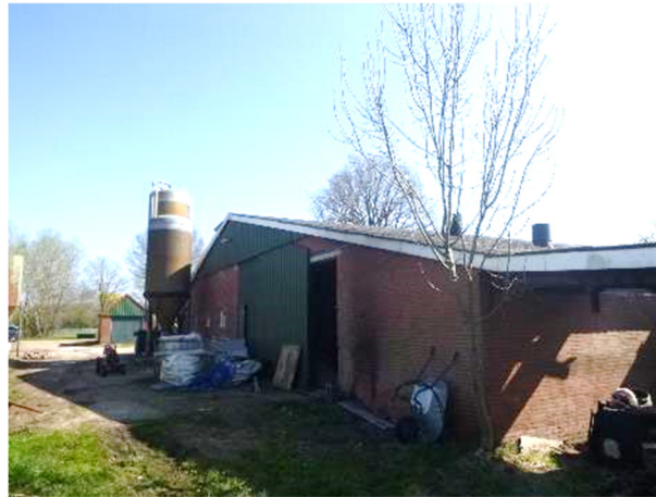
Te slopen schuur ten westen van boerderij met voormalige dieseltanklocatie A
