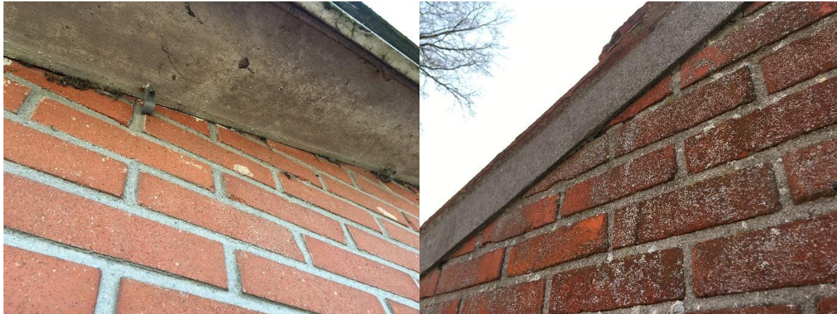
Foto links; betimmering van de overstek van het dak sluit naadloos aan op de buitengevels. Foto rechts; daklijsten sluiten naadloos aan op de buitengevels.
