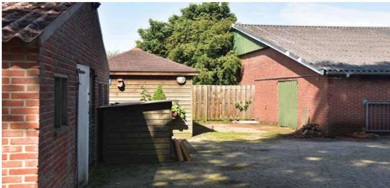
Achterzijde woning met zicht op te slopen schuren
