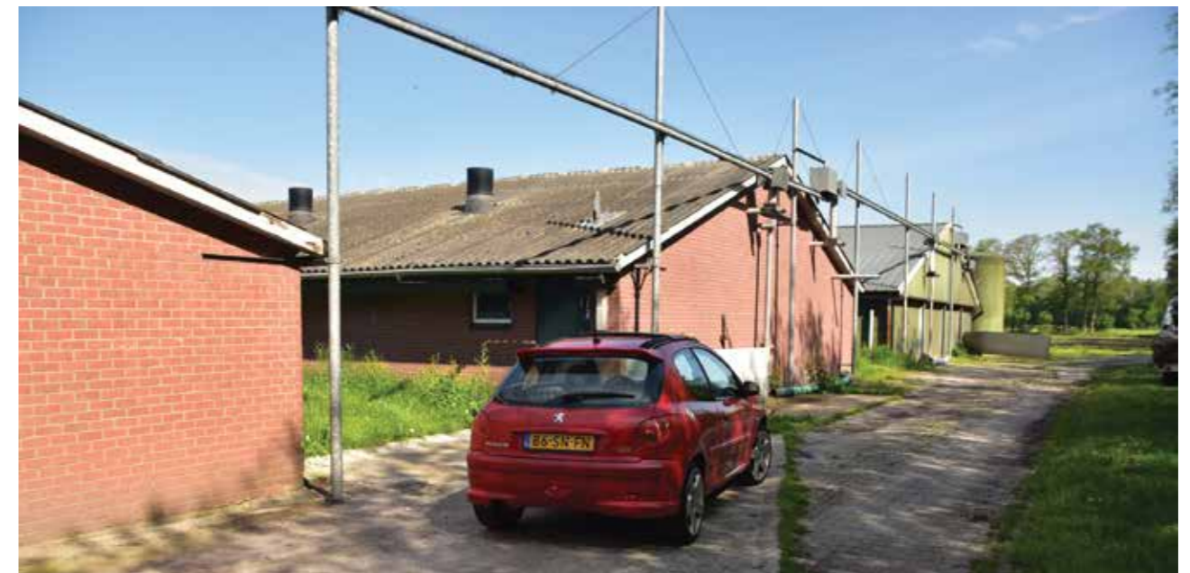
Werkgedeelte, de meest linkse schuur wordt gesloopt.
