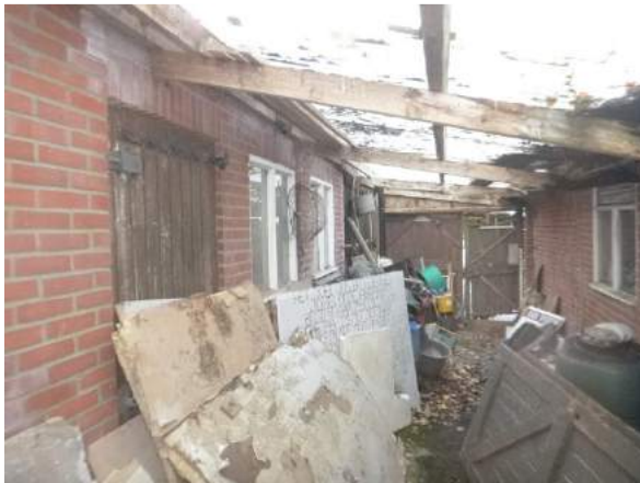
Afdak met lichtplaten tussen schuren 1 en 3
