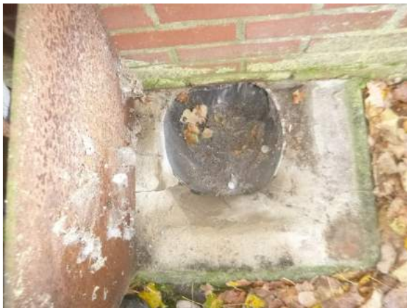
Inspectie pomp gat
