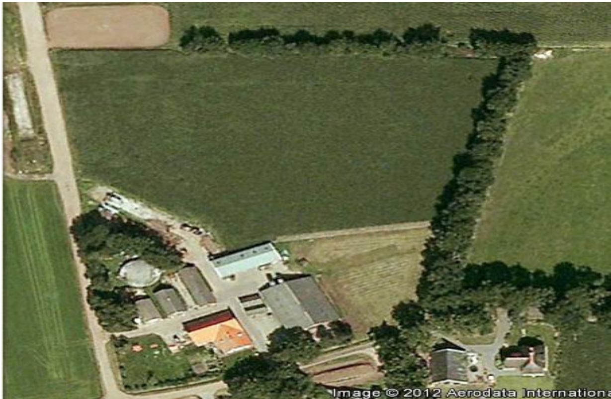
Image © 2012 Aerodata International Foto oude situatie[bron.google earth]
