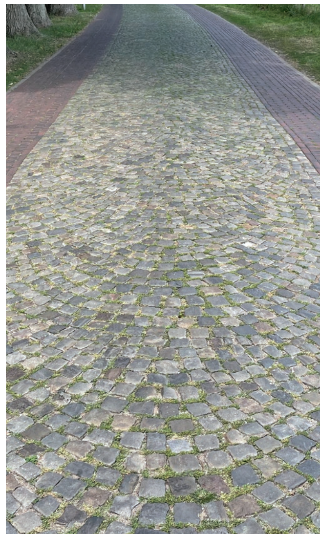
Verbijzondering in entreeweg met gezaagde keien, bijvoorbeeld basaltkeien of Zweeds graniet
