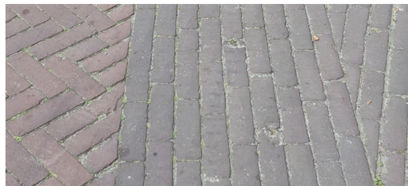
Gebakken klinker in keperverband en middengoot 9 strekken
