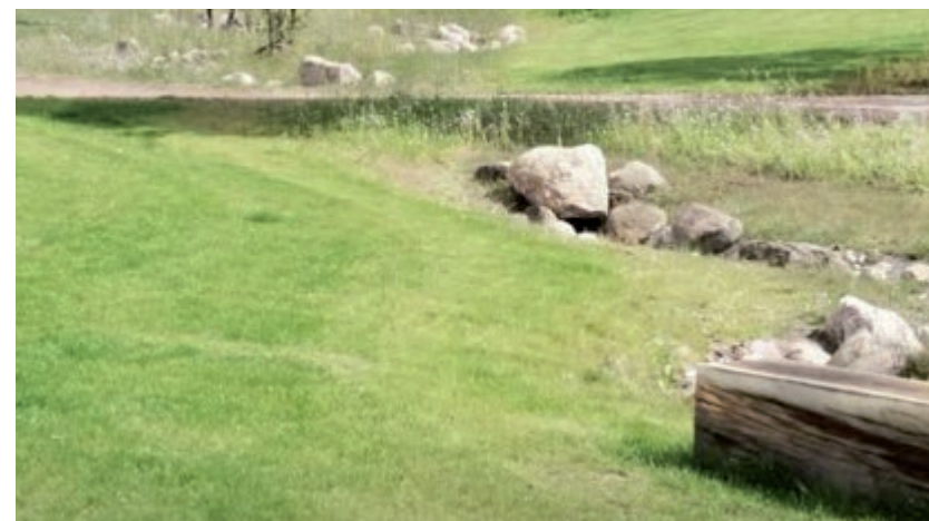
Uitstroomopeningen door middel van goten, bijvoorbeeld met basaltkeien of Zweeds graniet, aangevuld met grote granieten zwerfkeien
