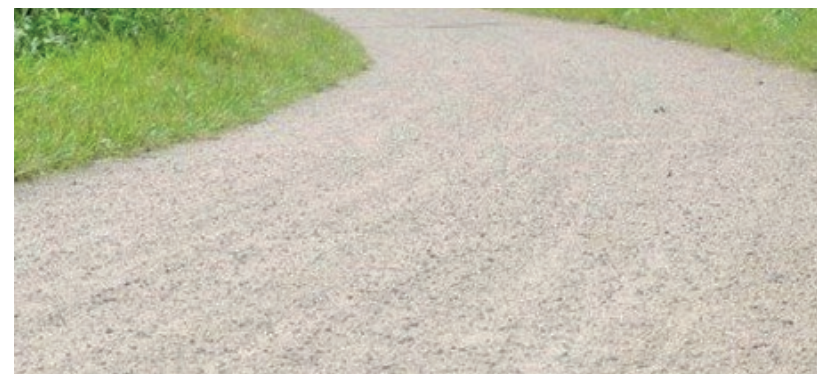
Halfverharding in zandige/grijze tint, in aansluiting op bestaande paden
