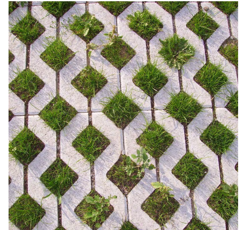
Halfverharding zoals Achterhoeks padvast of grasbetonstegeles voor stevige ondergrond en robuuste uitstraling. Bij weinig gebruik groeit het gras door de tegels en is het beton niet meer te zien.
