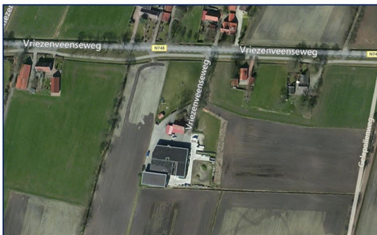
Figuur 1.3: Luchtfoto met bestaande bedrijfspand (bron: Google maps)
